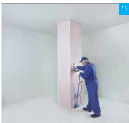
تکمیل پوشش کاری لایه دوم
