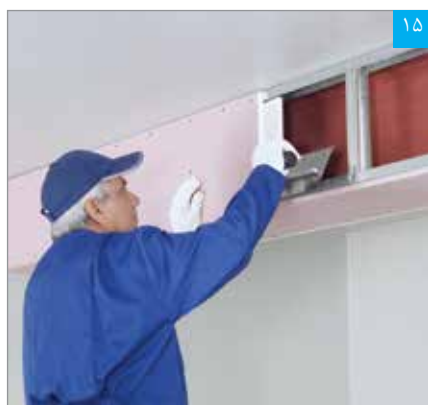
۱۵ اجرای بتونه درزگیر بر روی نیمه دیگر پنل پشت بند درز (پس از خشک شدن بتونه درزگیر نیمه اول)
