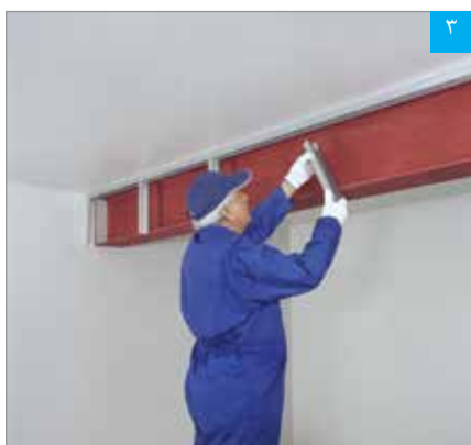
۳ اجرای سازه‌های قائم
