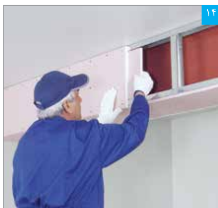
۱۴ اتصال پنل پشت بند درز به پنل جانبی
