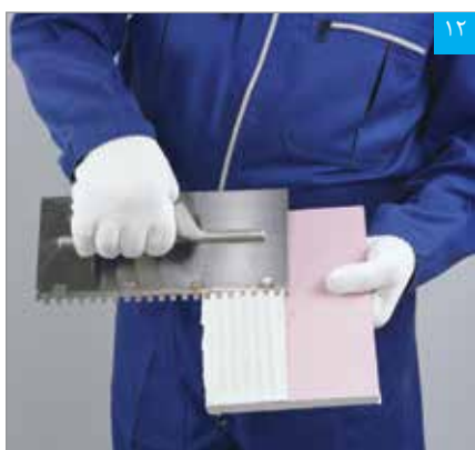
۱۲ اجرای بتونه درزگیر بر روی نیمی از پنل پشت بند درز (با استفاده از مالنه دندانه‌دار)
