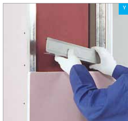
استقرار سازه پشت بند درز (ما بین لایه پوششی و زیرسازی)
