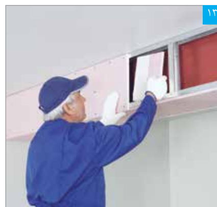
۱۳ استقرار پنل پشت بند درز
