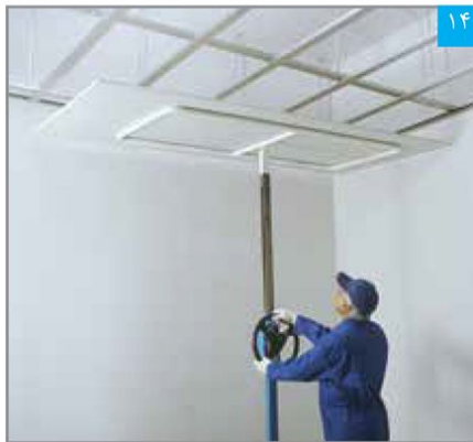
استقرار پنل با استفاده از بالابر
