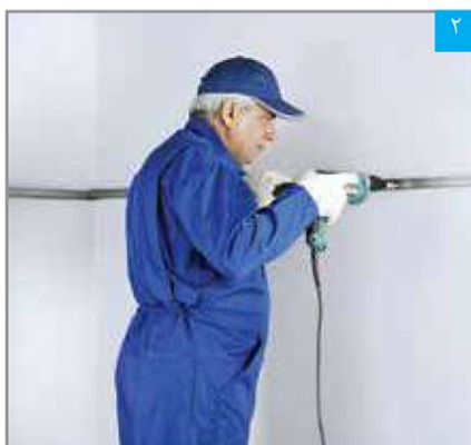
نصب سازه تراز
