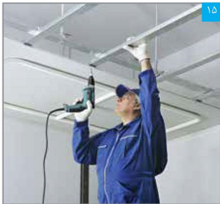
اتصال پنل به زیرسازی توسط پیچ
