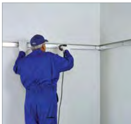
نصب سازه تراز باربر
