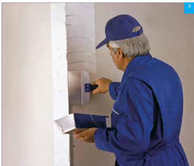
اجرای بتونه روی سازه محافظ گوشه
