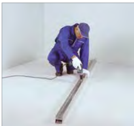
اجرای سازه سقفی دوتایی
