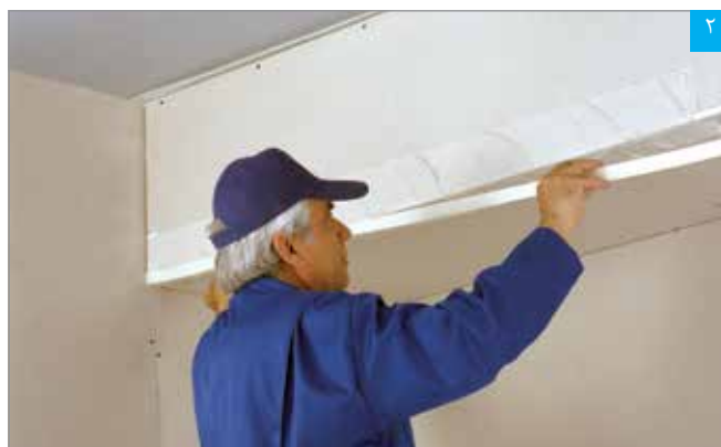
قرار دادن نوار درزگیر بر روی بتونه
