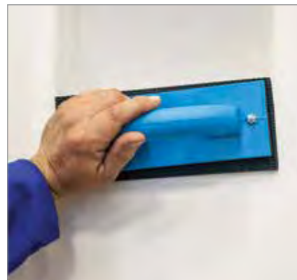
مرطوب کردن سطح دیوار با اسفنج نمدار
