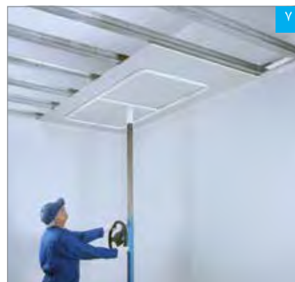
استقرار پنل با استفاده از بالابر
