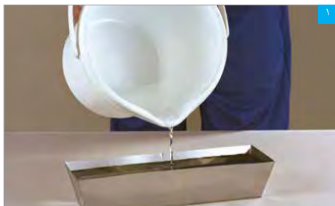
ریختن آب در ظرف تهیه بتونه
