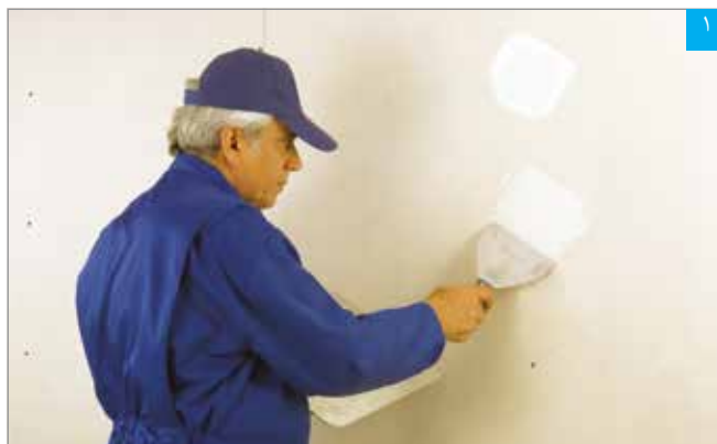
اجرای بتونه در محل پیچ‌ها
