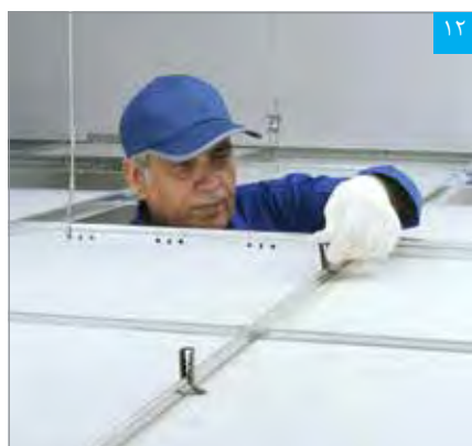
قراردادن گیره‌های مخصوص نگهدارنده تایل
