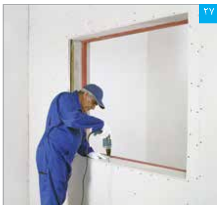
اتصال پنل نواری به سازه قاب‌بندی تحتانی
