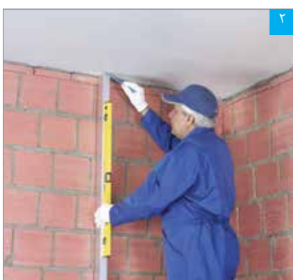
شمه‌گذاری بر روی دیوار زمینه، جهت تعیین ناترازی آن و علامت‌گذاری روی سقف
