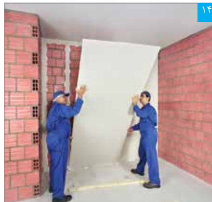
پنل به سادگی توسط دو نفر قابل بلند کردن است
