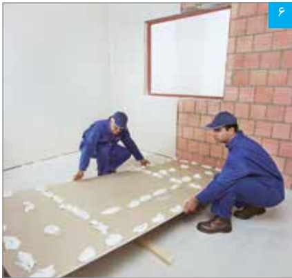
به نحوه اجرای چسب گچی پنل (بوردفیکس) در محل بازشوی پنجره توجه شود
