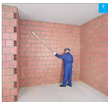
شمه‌گذاری به صورت مایل بر روی دیوار زمینه، جهت بررسی ناهمواری در طول دیوار
