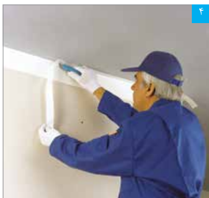
برش اضافات نوار چسب جداکننده پس از خشک شدن بتونه
