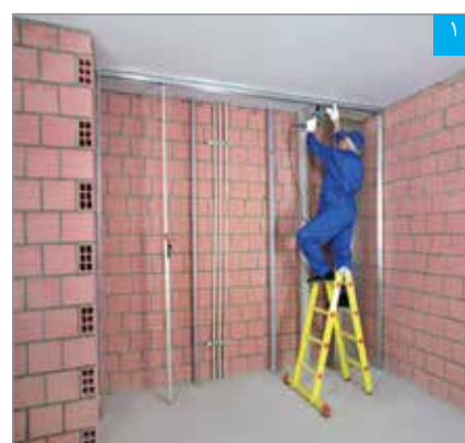
اجرای قاب پیرامونی (به روش مشابه ساختار W625.ir)
