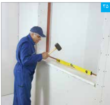
نصب و تنظیم سنگ کف پنجره
