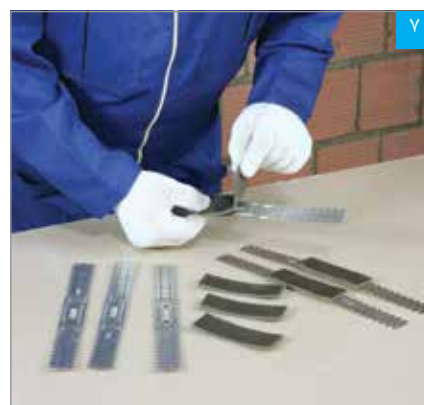
۷ نصب قطعات فوم (عایق) بر پشت براکت‌ها
