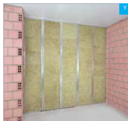
لایه عایق تکمیل شده
