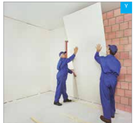
استقرار پنل بر روی دیوار زمینه
