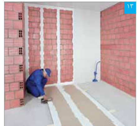
لایه نواری بتونه درزگیر را می‌توان بر پشت پنل‌ها اجرا نمود
