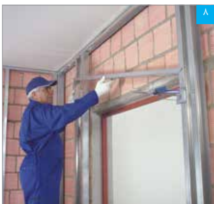
استقرار رانر قاب‌بندی فوقانی (به جهت خم‌ها توجه شود)
