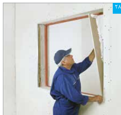
استقرار پنل نواری در ناحیه داخلی دور بازشوی پنجره (به اجرای یکپارچه چسب گچی پنل (بوردفیکس) توجه شود)
