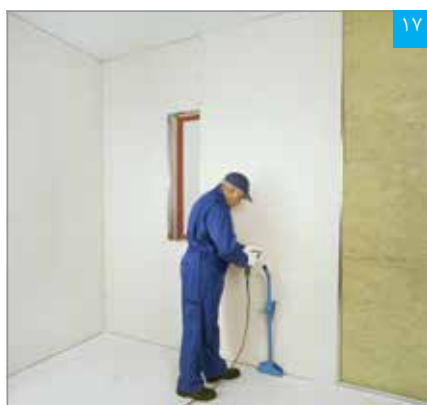
نصب پنل بر روی زیرسازی
