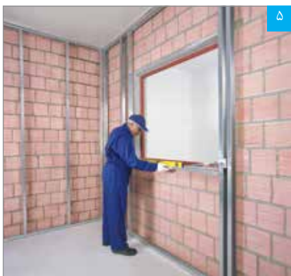
تنظیم رانر قاب‌بندی تحتانی به وسیله تراز
