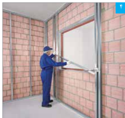
استقرار رانر قاب‌بندی تحتانی (به جهت خم‌ها توجه شود)
