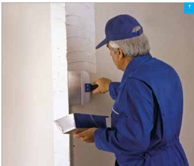
اجرای بتونه روی سازه محافظ گوشه
