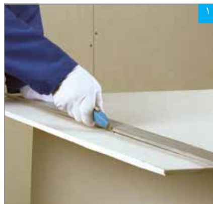
ایجاد شیار (برش کاغذ روکش) بر روی پنل
