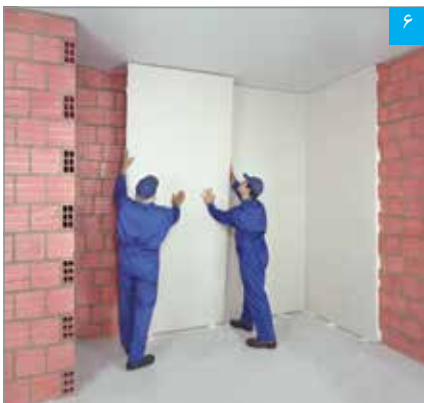
استقرار پنل بر روی دیوار زمینه
