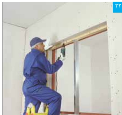
اتصال پنل نواری به سازه قاب‌بندی فوقانی
