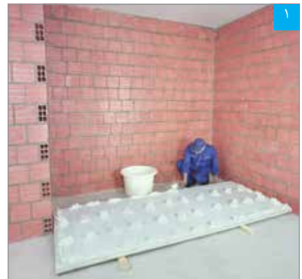
اجرای چانه‌های چسب گچی پنل (بوردفیکس) بر پشت پنل مرکب PS
