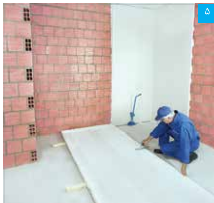
اجرای لایه بتونه درزگیر (به صورت شانه‌ای) بر پشت پنل مرکب PS
