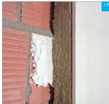
ضخامت چانه چسب گچی پنل (بوردفیکس) پس از نصب و فشردن پنل باید حداقل ۵ میلی‌متر باشد
