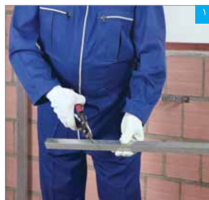
برش انتهای سازه‌های افقی قاب‌بندی بازشوی پنجره (به اندازه ۲۰ سانتی‌متر و به صورت فارسی بر)
