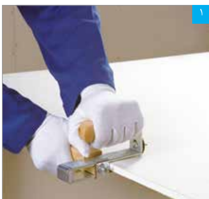
برش پنل با دستگاه برش قرقره‌ای
