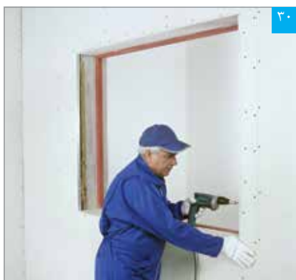
اتصال پنل نواری به سازه قائم
