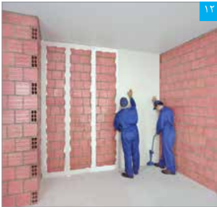
نصب پنل با استفاده از جک نگهدارنده
