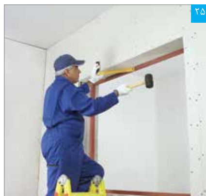
تنظیم پنل نواری (گونیا کردن)
