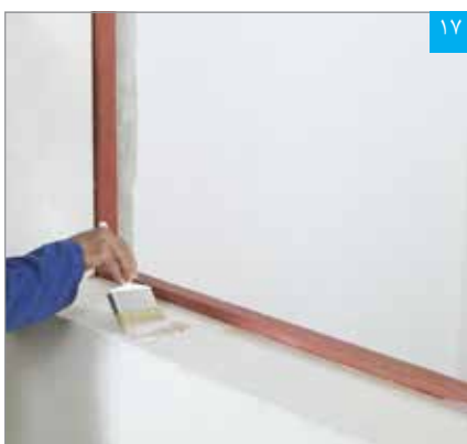
اجرای پرایمر بر روی سطح پنل
