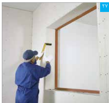
تنظیم پنل نواری (گونیا کردن)
