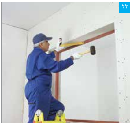
تنظیم پنل نواری (گونیا کردن)
