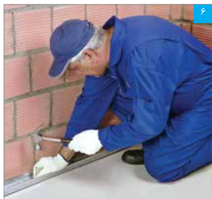
نصب رانر کف
