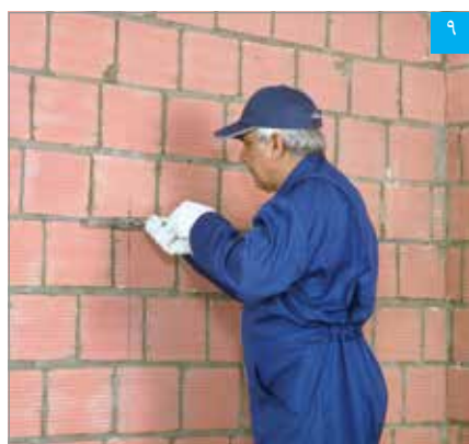
۹ نصب براکت بر روی دیوار زمینه
