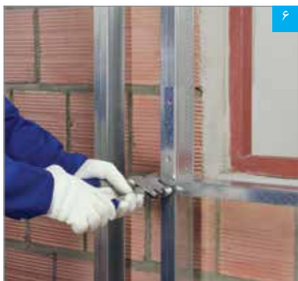
اتصال رانر قاب‌بندی تحتانی به استاد به وسیله پانچ، پرچ یا پیچ (به جهت برش ۴۵ درجه توجه شود)
