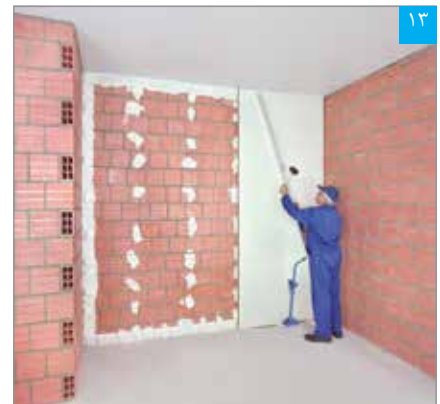
تنظیم نهایی پنل نصب شده با شمشه و چکش لاستیکی
