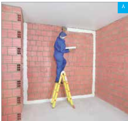
اجرای چسب گچی پنل (بوردفیکس) به صورت نوار پیوسته در حاشیه پیرامونی دیوار زمینه
