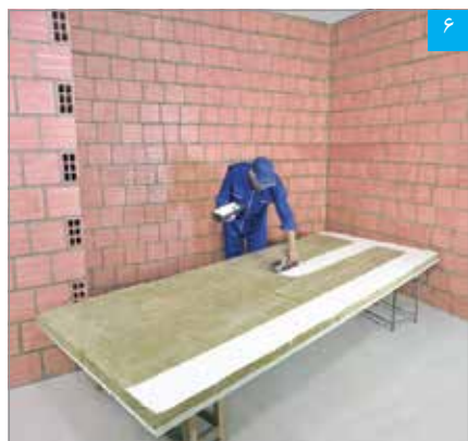
اجرای لایه نواری چسب گچی پنل (بوردفیکس) بر روی لایه پشم معدنی (پشت صفحه مرکب MW)
