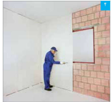
برش پنل با استفاده از اره
