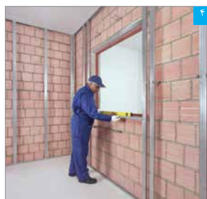
تنظیم سازه قاب‌بندی به وسیله تراز
