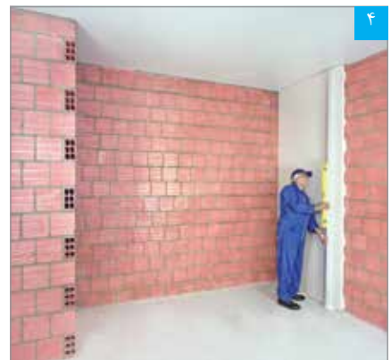
بررسی تراز و تنظیم بودن پنل نصب شده با استفاده از شمشه و تراز
