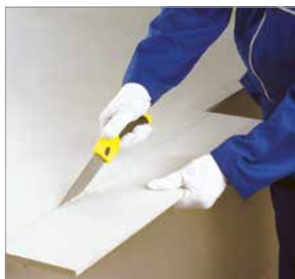
برش پنل با اره دستی
