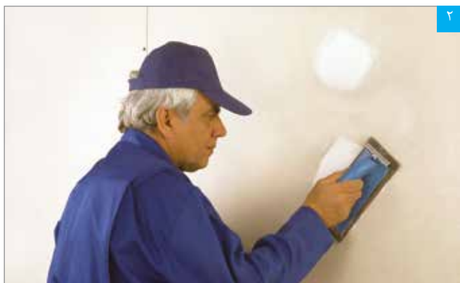
پرداخت سطح بتونه خشک
