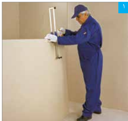
برش پنل با دستگاه برش طولی
