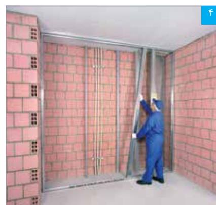
استقرار استادهای دوتایی در رانرها (به صورت شاقولی)
