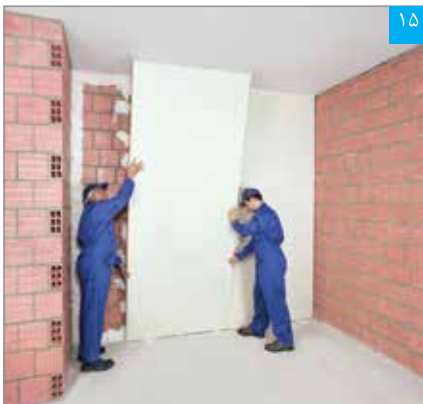
پنل‌ها بر روی محور مرکزی ردیف‌های چسب گچی پنل (بوردفیکس) مستقر می‌شوند
