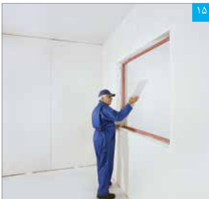
استقرار پنل نواری در ناحیه داخلی دور بازشوی پنجره
