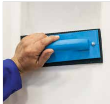
مرطوب کردن سطح دیوار با اسفنج نمدار
