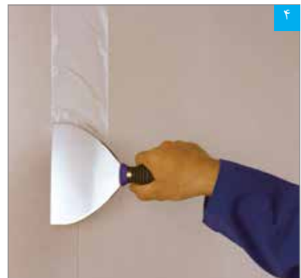
مرحله اول درزگیری: اجرای لایه بتونه در محل درز (کاردک در جهت عمود بر درز کشیده می‌شود تا بتونه کاملاً در درز نفوذ کند)
