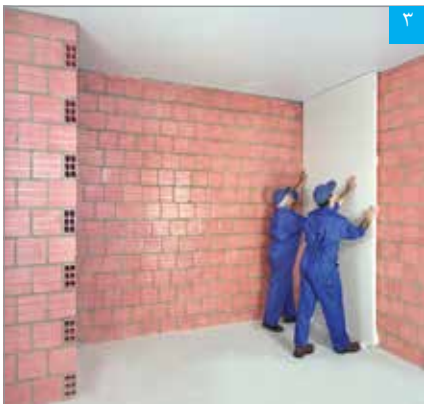
استقرار پنل بر روی دیوار زمینه
