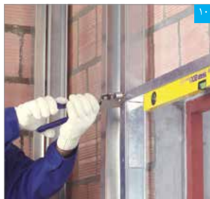
اتصال رانر قاب‌بندی فوقانی به استاد به وسیله پانچ، پرچ یا پیچ (به جهت برش ۴۵ درجه توجه شود)
