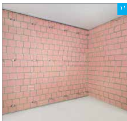
۱۱ براکت‌های نصب شده
