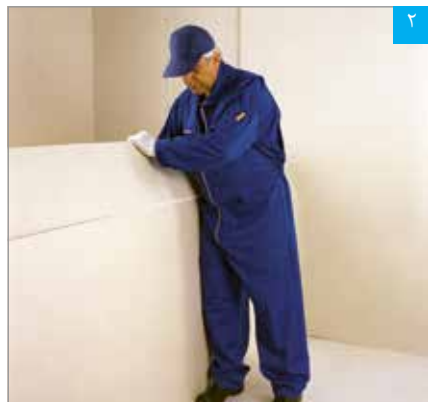
شکستن پنل در محل برش
