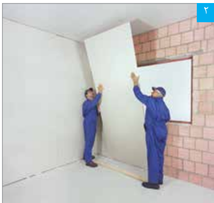
استقرار پنل بر روی دیوار زمینه
