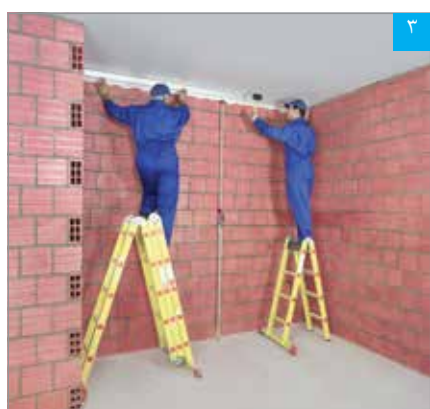
نصب و تنظیم کرم بالا با شمشه و چکش لاستیکی
