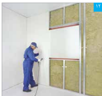
نصب پنل بر روی زیرسازی
