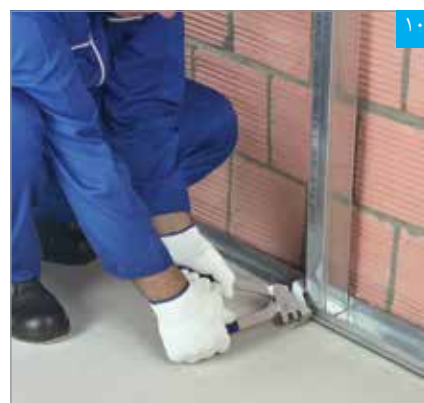
اتصال و تثبیت استادها به رانرها (به وسیله پانچ، پرچ یا پیچ)
