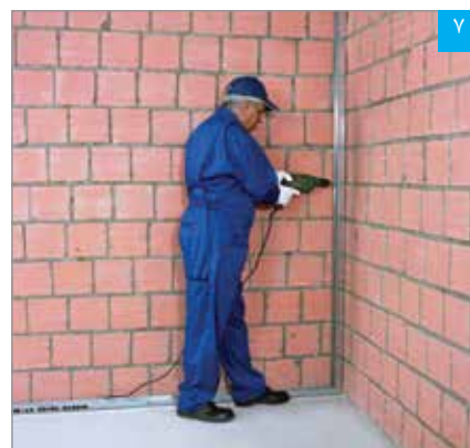
نصب اولین استاد بر روی ساختار جانبی
