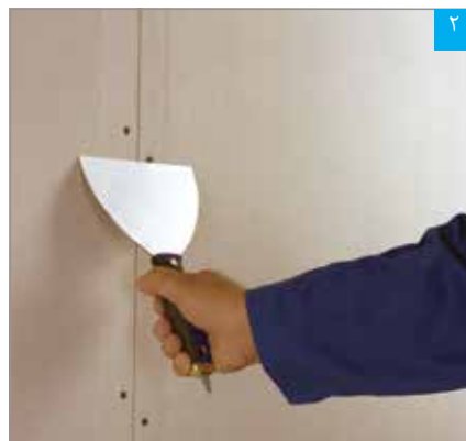
بررسی بیرون‌زدگی پیچ‌ها با کاردک
