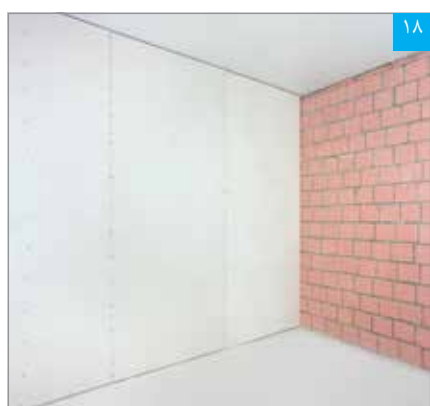
دیوار پوششی تکمیل شده
