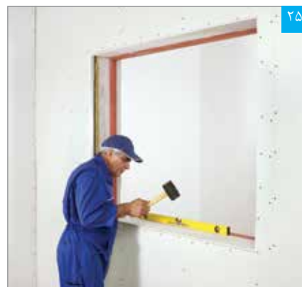
تنظیم پنل نواری (تراز کردن)
