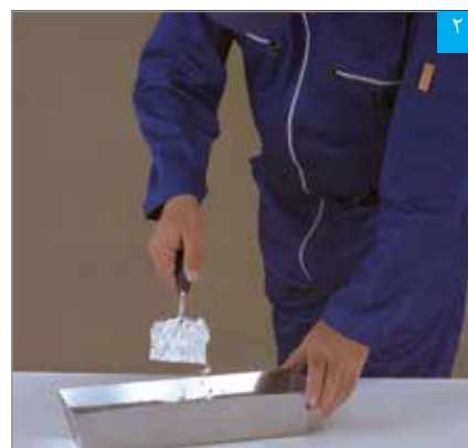
ریختن پودر بتونه در آب
