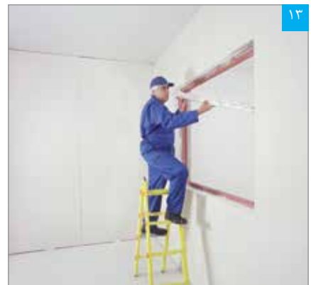
استقرار پنل نواری در ناحیه داخلی دور بازشوی پنجره
