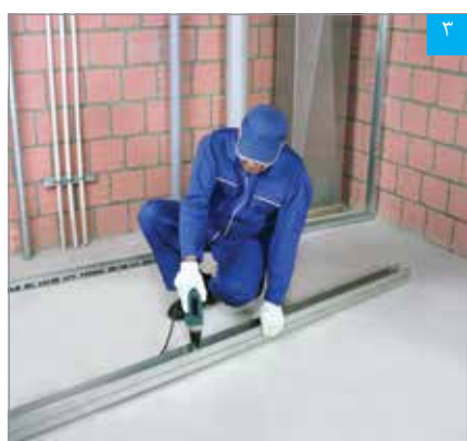
اجرای استادهای دوتایی
