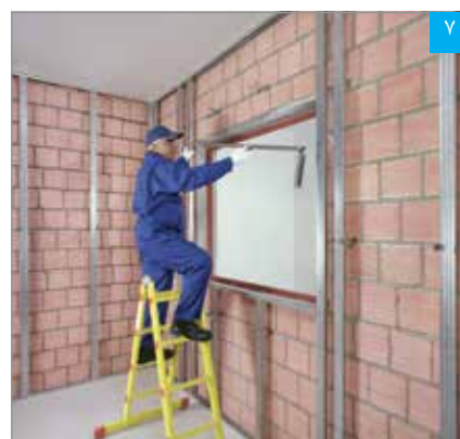
استقرار سازه قاب‌بندی فوقانی (به جهت خم‌ها توجه شود)
