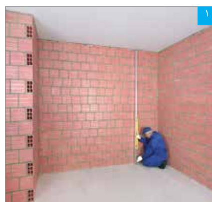
شمه‌گذاری بر روی دیوار زمینه، جهت تعیین ناترازی آن و علامت‌گذاری روی کف
