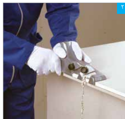
اجرای پخ با پخ زن
