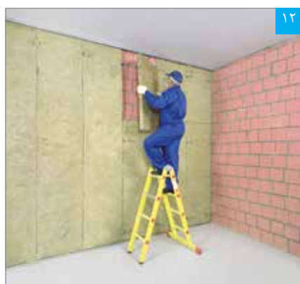
۱۲ اجرای عایق پشم معدنی
