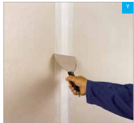
مربوط کردن سطح نوار با بتونه‌های اضافه
