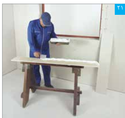
اجرای چسب گچی پنل (بوردفیکس) بر پشت پنل نواری (به اجرای یکپارچه چسب گچی پنل توجه شود)
