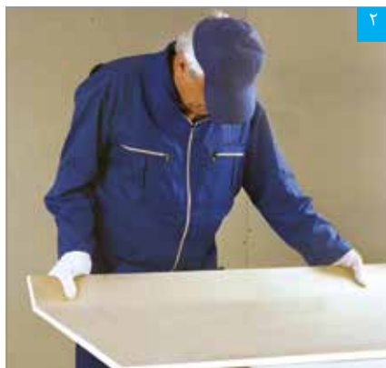
شکستن پنل در محل برش
