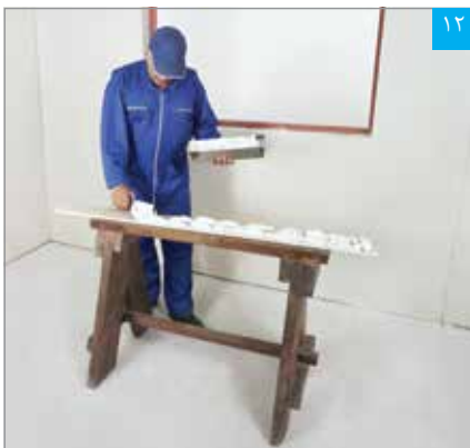
اجرای چسب گچی پنل (بوردفیکس) بر پشت پنل نواری (برای پوشش کاری ناحیه داخلی دور بازشوی پنجره)
