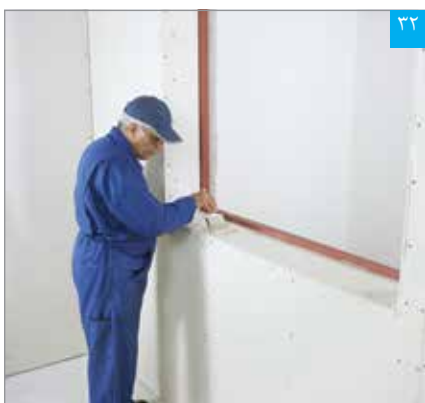
اجرای پرایمر بر روی سطح پنل
