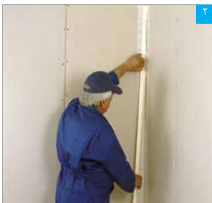
قرار دادن نوار درزگیر بر روی بتونه
