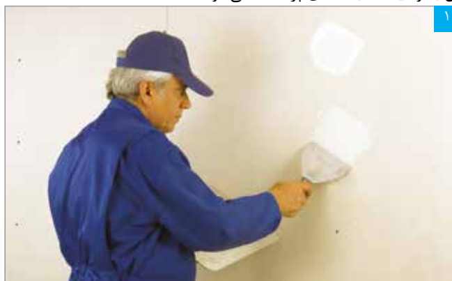
اجرای بتونه در محل پیچ‌ها
