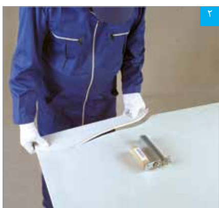
جداکردن پنل از محل برش
