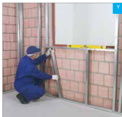
استقرار استادها در رانر کف و رانر قاب‌بندی تحتانی
