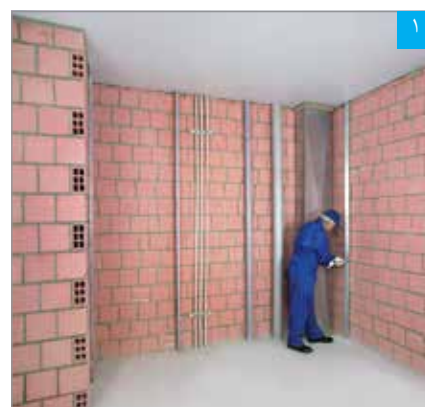
۱ نصب اولین رانر بر روی ساختار جانبی
