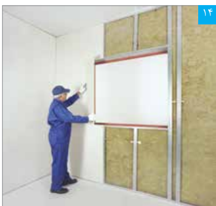
برش پنل با استفاده از تیغ برش
