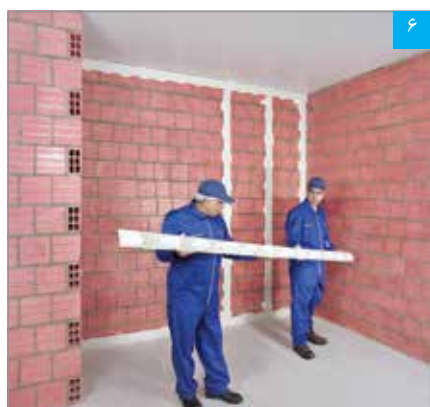
چانه‌های چسب گچی پنل (بوردفیکس) در فواصل حداکثر ۳۵ سانتی‌متر (مرکز به مرکز) بر پشت کرم ها قرار می‌گیرند
