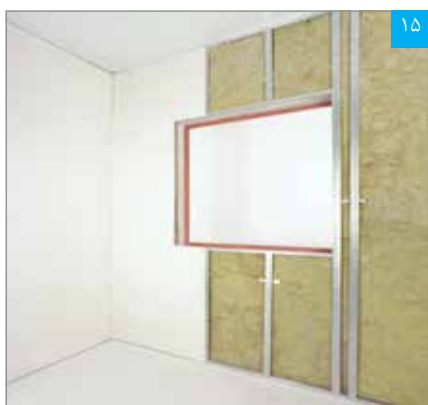
در محل بازشوی پنجره، برش پنل به صورت «C» شکل صورت می‌گیرد
