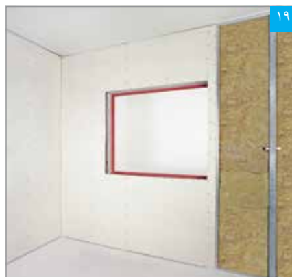
پوشش کاری تکمیل شده در ناحیه بیرونی بازشوی پنجره
