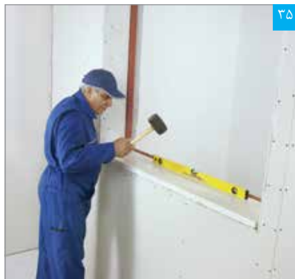
نصب و تنظیم سنگ کف پنجره
