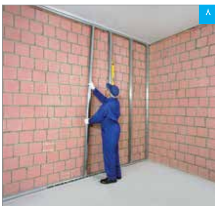
اجرای استاداها (به صورت شاقولی)
