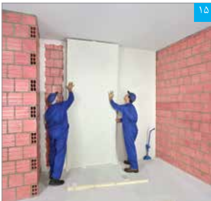
پنل‌ها بر روی محور مرکزی کرم‌ها مستقر می‌شوند
