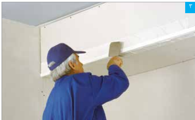
تثبیت و شکل دهی نوار درزگیر با کاردک زاویه خارجی
