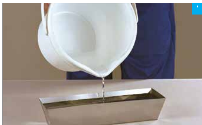
ریختن آب در ظرف تهیه بتونه
