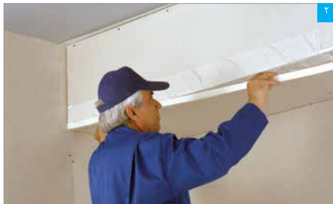
قرار دادن نوار درزگیر بر روی بتونه
