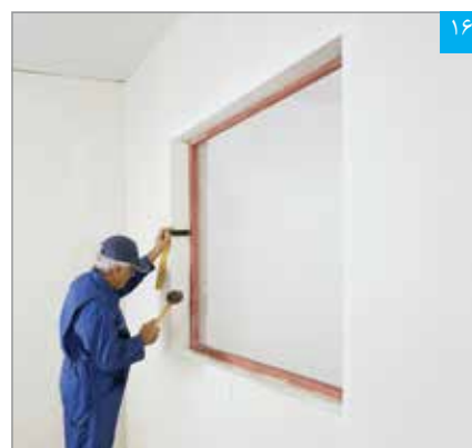
نصب و تنظیم پنل نواری
