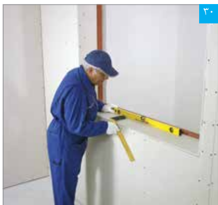
تنظیم پنل نواری (گونیا و تراز کردن)
