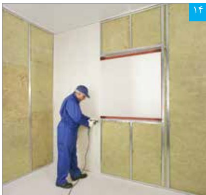
نصب پنل بر روی زیرسازی
