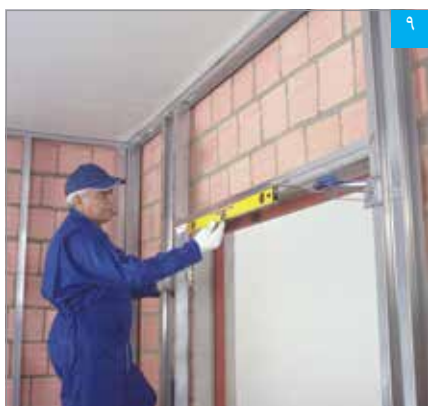
تنظیم رانر قاب‌بندی فوقانی به وسیله تراز
