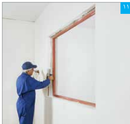
اجرای چسب گچی پنل (بوردفیکس) بین پنل و دیوار بنایی (دور تا دور بازشوی پنجره)
