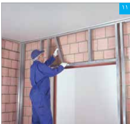
استقرار استادها در رانر سقف و رانر قاب‌بندی فوقانی
