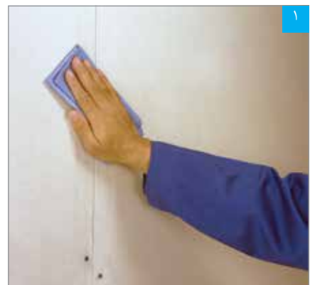
تمیز کردن سطح، قبل از بتونه‌کاری و یا اجرای ماستیک بسیار مهم است
