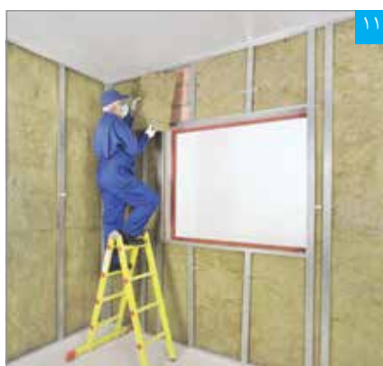
اجرای عایق پشم‌معدنی
