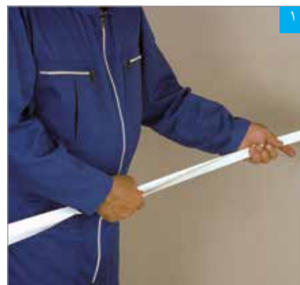
خم کردن نوار درزگیر با دست
