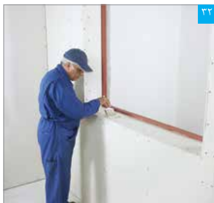
اجرای پرایمر بر روی سطح پنل
