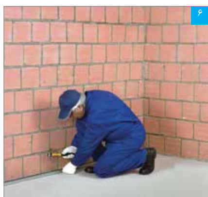
۶ نصب سازه هادی کف
