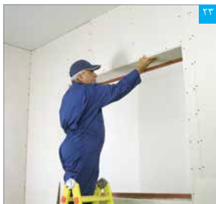
تنظیم لبه های پنل در محل کنج
