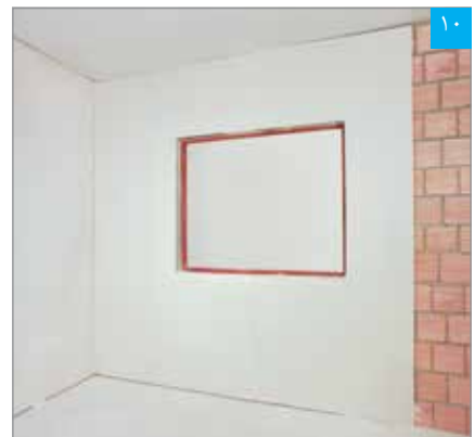
پوشش کاری تکمیل شده در ناحیه بیرونی بازشوی پنجره
